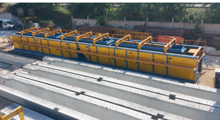
Forma i sprężone belki mostowe, widok z lotu ptaka.
