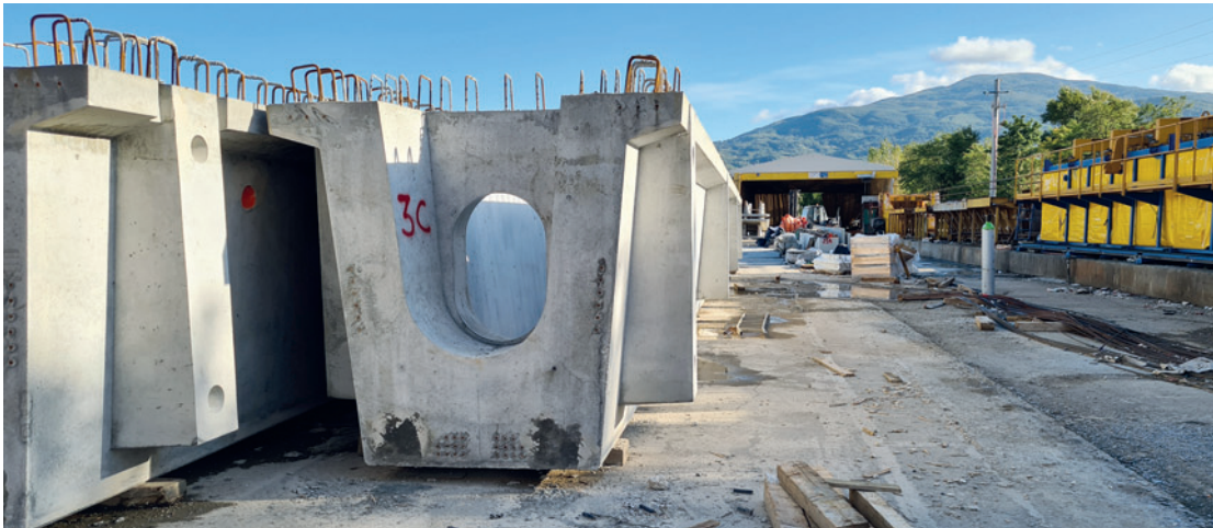
Sprężone belki mostowe, widok z przodu.
