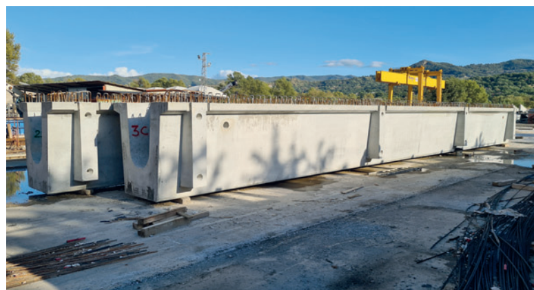
Sprężone belki mostowe, widok z boku.
