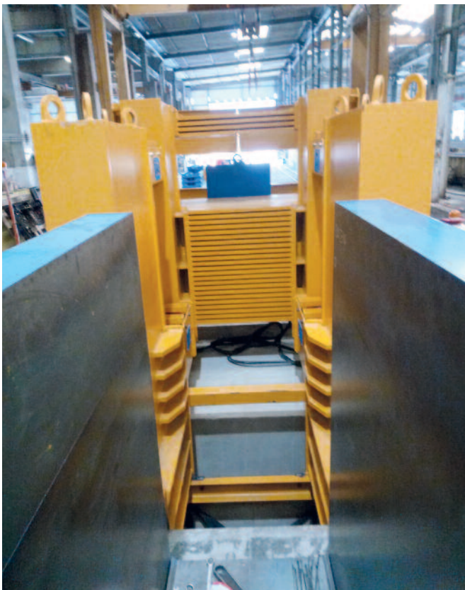
Konstrukcja oporowa do kotwienia ciągnięć sprężających.
