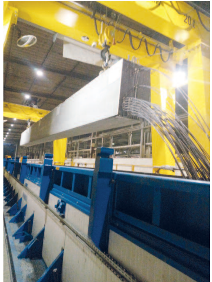
Rozformowywanie belek o przekroju prostokątnym.
