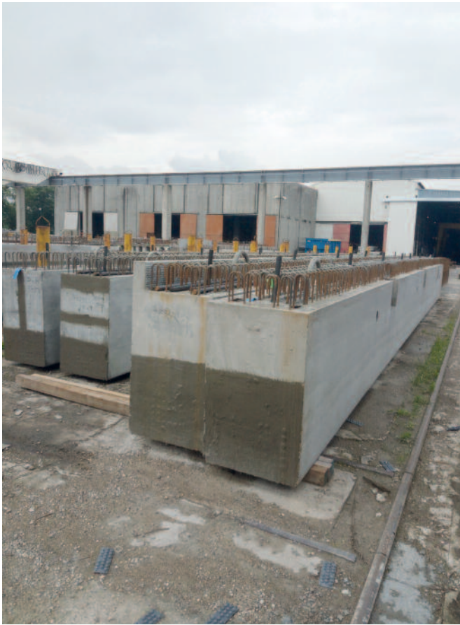
Rozformowane belki o przekroju prostokątnym na zewnętrznym placu składowym w zakładzie w Grigny.
