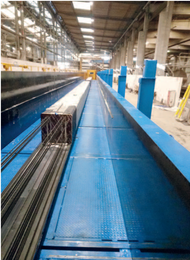
Siłowniki zwalniające ciągną i kołnierze zabezpieczające na elementach oporowych.
