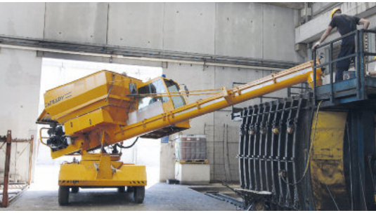
Nachylony wysięgnik umożliwia podawanie mieszanki betonowej na wysokość nawet do 3 500 mm.
