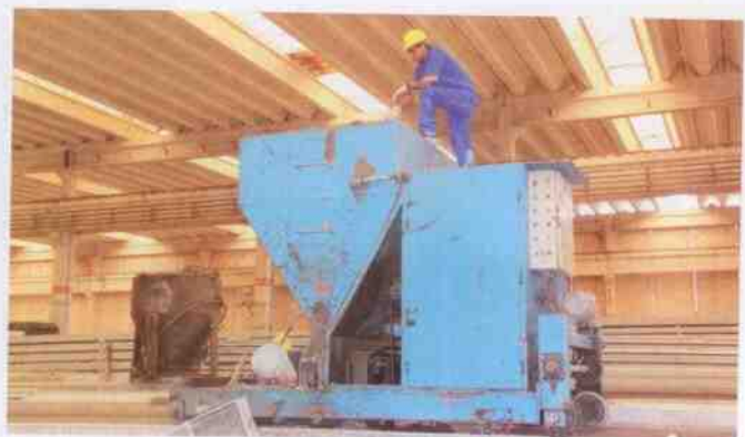
Stary ekstruder podczas betonowania.
